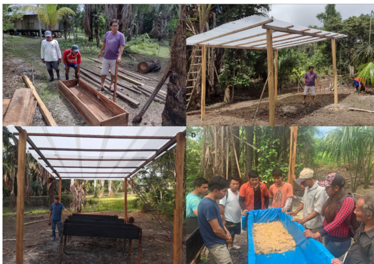
Figura 2. Fabricação de caixas de madeira para a produção da mosca soldado negra. A. Trabalhadores construindo as caixas, B. Cobertura para as caixas. C. Caixas acabadas sob um teto coberto. D. Caixas de madeira em operação.
