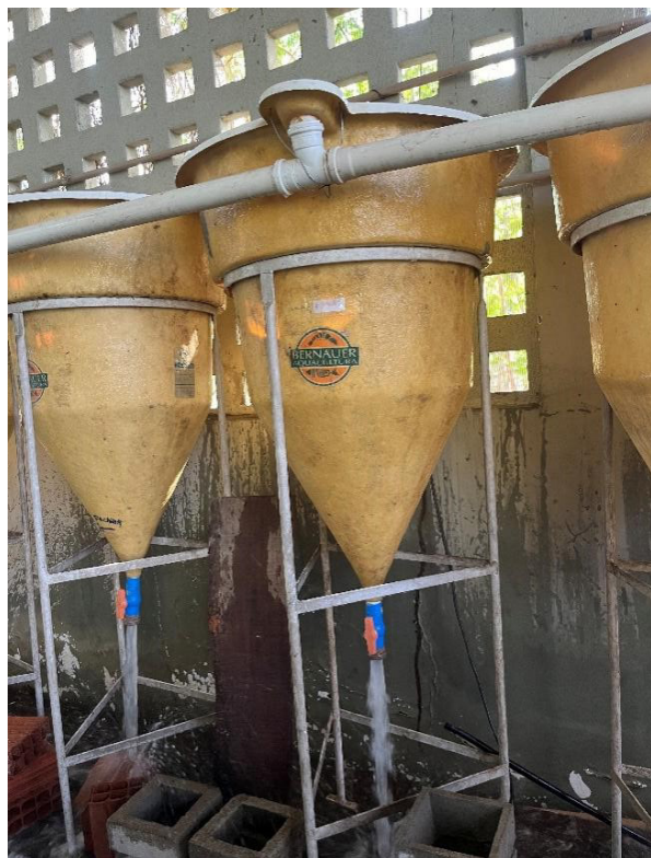
Figura 1. Tanques cilíndricos cônicos com capacidade para 250L de água, com recirculação de água. Fonte: Jéssica Antonia Cardoso Mendes (2024)
